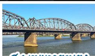
สะพานขาดตานตง
